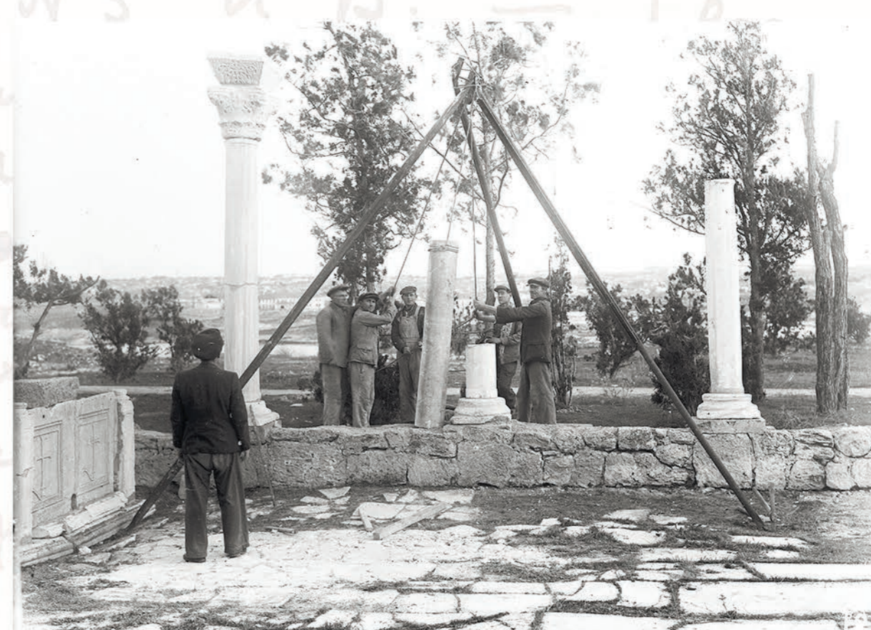
Базлика VI в. н. э. у Владимирского собора. Установка колонн. Ноябрь 1947 г.
